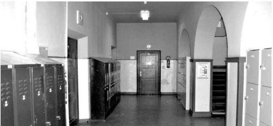
Der Flur vor den Klassenzimmern im Altbau : Vorher ...
