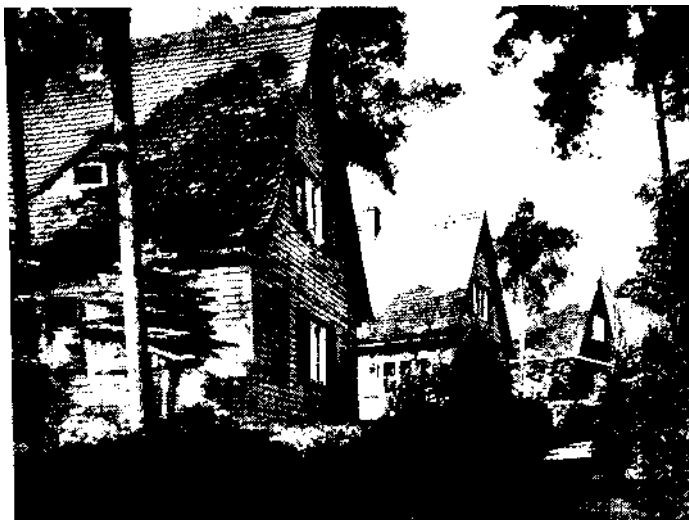
Villenviertel „Am Sonnenhang“
