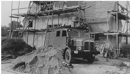
Die Feuerwehr pumpt den Keller leer
