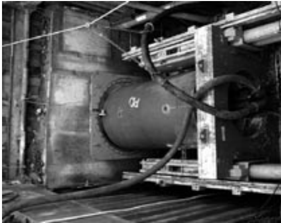
Hydraulikzylinder drücken ein Rohr in den Tunnel.
