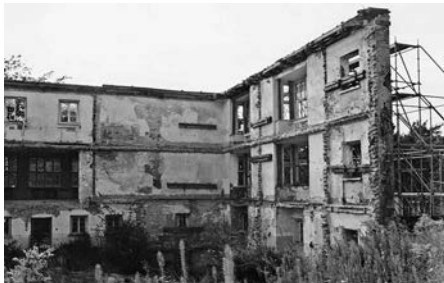
Zustand 1999 vor Rekonstruktion
