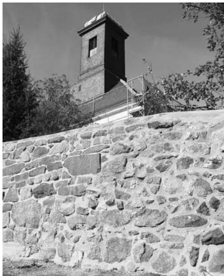
Sanierte Mauer am Kirchsteig
